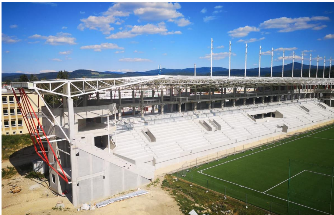
Výstavba futbalového štadióna v Trenčíne.
